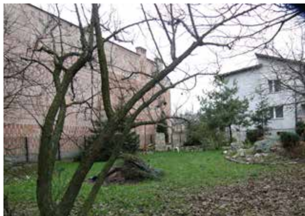
Budynek jednorodzinny dosunięty do granicy powoduje utrudnienia w zagospodarowaniu działki sąsiedniej fot. Bożena Nieroda (2009)
