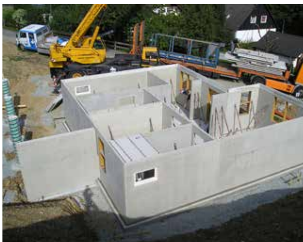
Prefabrykacja budynków (fot. kellerbau.de)
